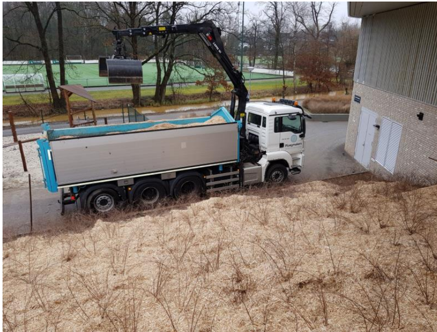
Figuur 3 Het aanbrengen van een Miscanthus mulchlaag in Eindhoven
