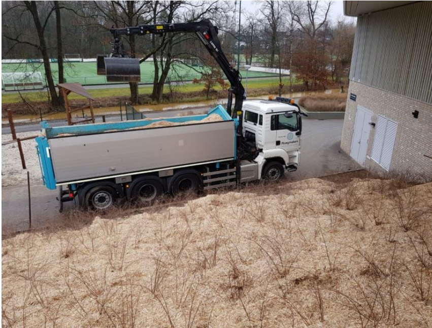
Figuur 3 Het aanbrengen van een Miscanthus mulchlaag in Eindhoven
